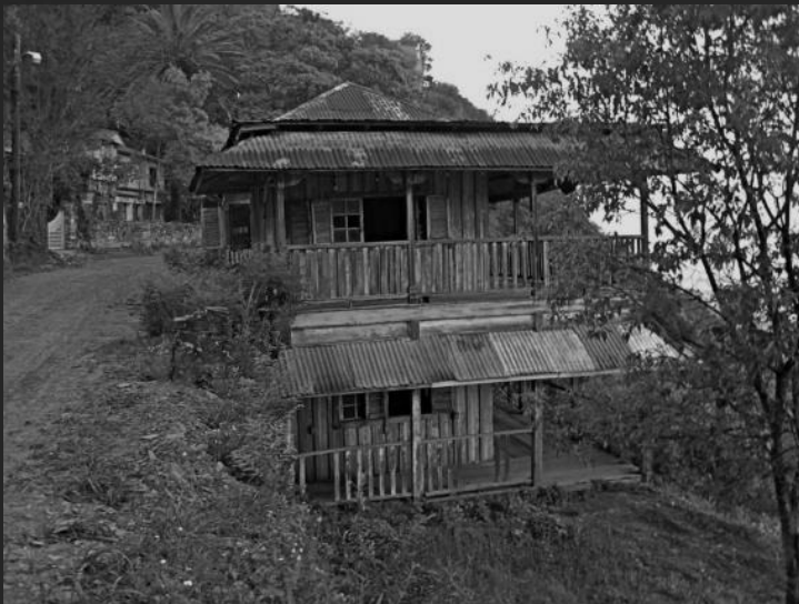
Casa la Periquera, o la volada
